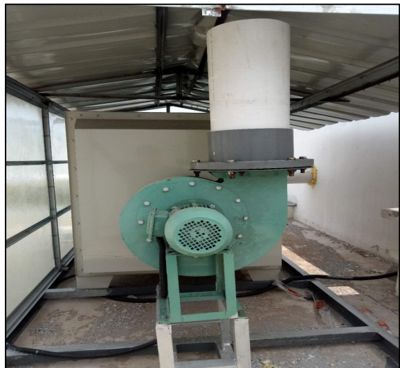
VOC 光氧废气处理机及楼顶 15 米排气筒
