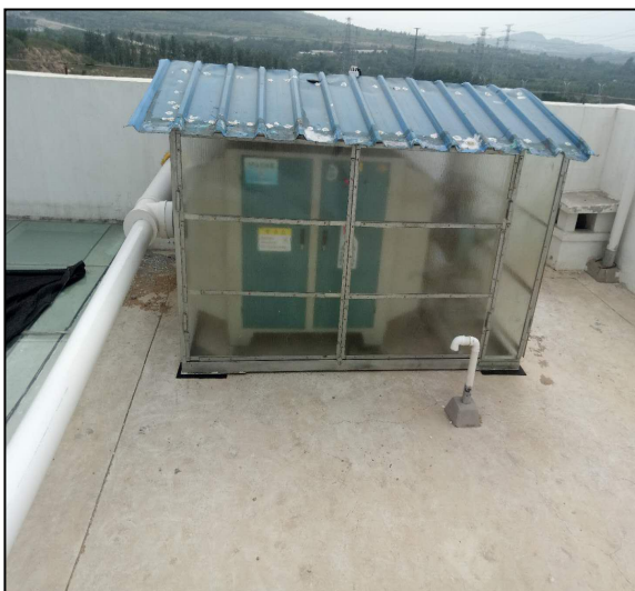
VOC 光氧废气处理机及楼顶 15 米排气筒
